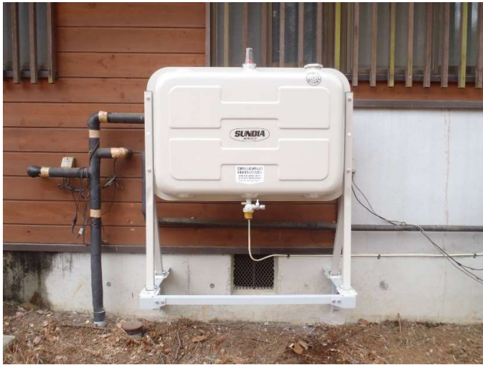
灯油タンクと凍結防止帯
